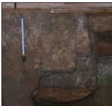
Fotografia 15. Basament pilar UE4.013
