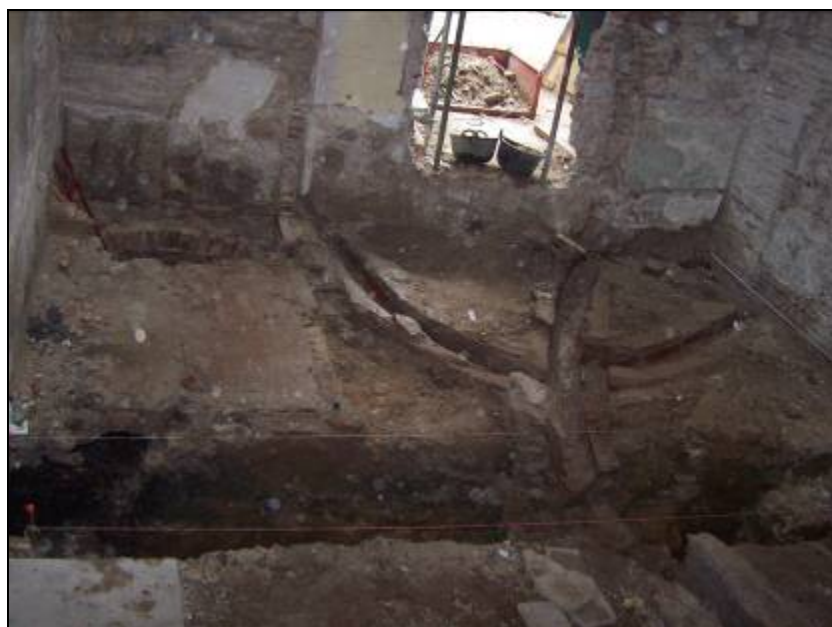
Fotografia 13. Sistema de clavueram s. XIX finca Hospital 140
