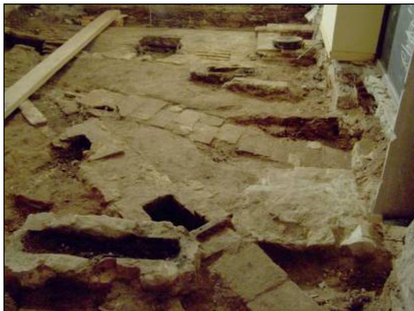
Fotografia 1. Sistema de clavegueram s. XIX finca Hospital 142.
