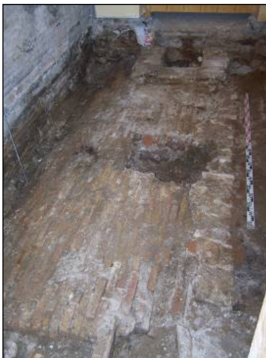
Fotografia 4. Fossa sèptica UE10.013
