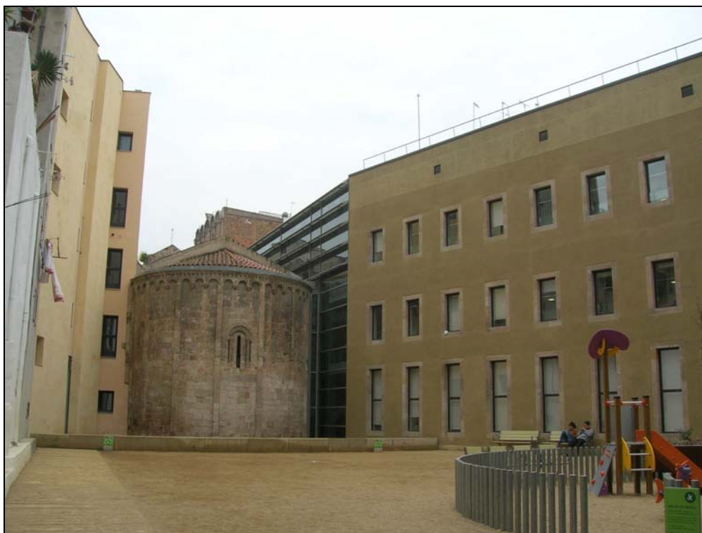
Fotografia 53. Vista general pati actual
